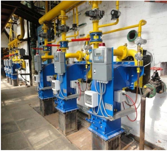
Модернізація котла на основі Пальникового пристрою СНТ в м. Рівному.
