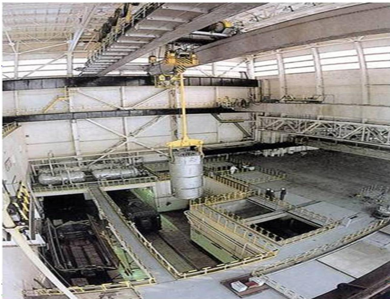
Рис.14.9. “Сухое” хранилище отработавшего ядерного топлива и радиоактивных отходов.
